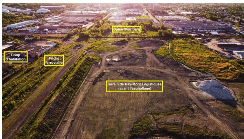
Figure 6 – Photo du terrain vague et identification des différents tronçons 8 .
